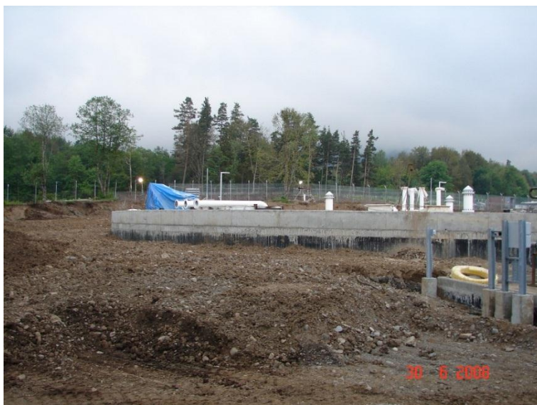
სურ. 58 დაღვრილი ნავთობის განსათავისუფლებლად აგებული ჩამოსაცლელი ავზი (სოფ. ციხისჯვარი)
