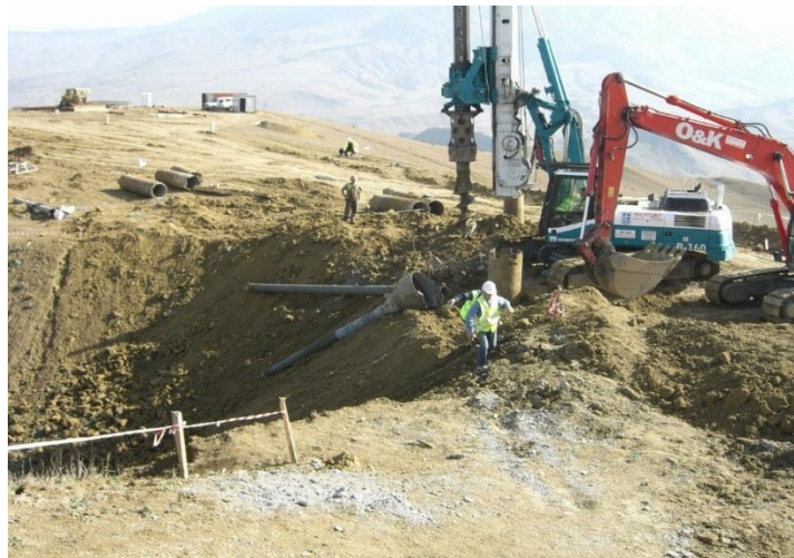
სურ. 57. დამცავი კედლის მშენებლობა ე.წ. „მინამის“ მეწყრის უბანზე
