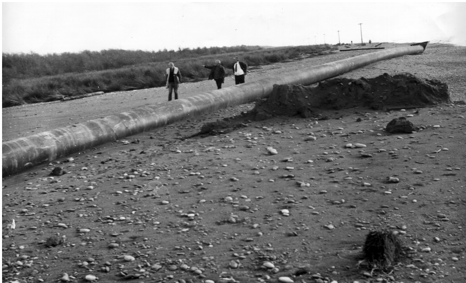
სურ. 19. შავი ზღვის დიუნა ჭაობის მცენარეულობით; საცდელი მილი ჭაობის წყლების ზღვაში განტვირთვის ექსპერიმენტის ჩატარების შემდეგ (1980)
